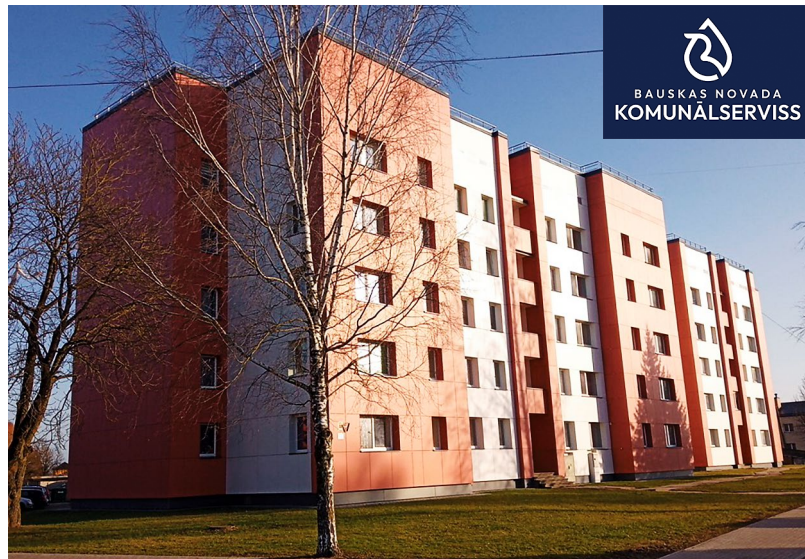
Daudzdzīvokļu ēka Bauskā, Salātu ielā 33 - pēc energoefektivitātes / atjaunošanas remonta darbiem, kuri veikti valsts kapitālsabiedrības ALTUM Daudzdzīvokļu māju energoefektivitātes 2016–2023 programmas ietvaros.
