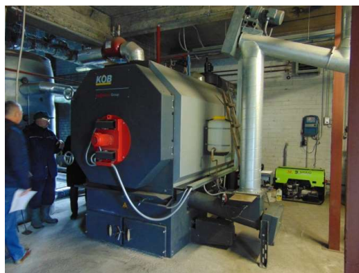
2.7.ATTĒLS: Šķeldas katls katlu mājā Bauskā (pa kreisi) un granulu katls katlu mājā Garozā (pa labi)
