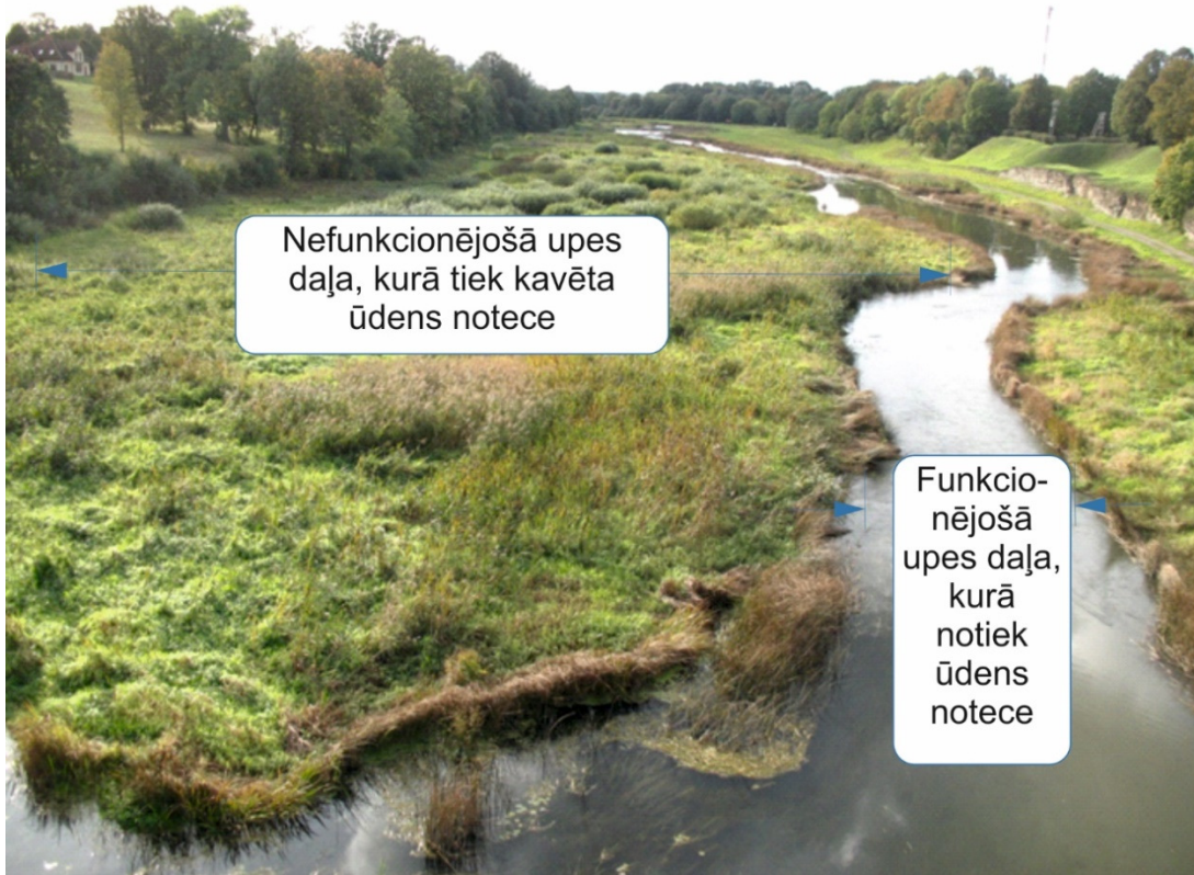
3.3.1.attēls. Mūsas upes posms, kurā kavētās ūdens noteces dēļ notiek krasta izskalošanās
