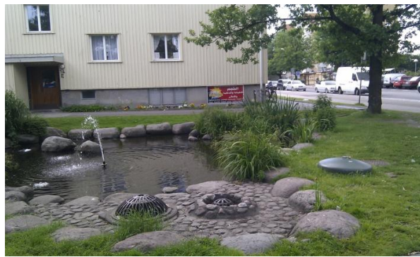
45. attēls. Lonngatan ielas lietusūdeņu koridora galā ir izveidots dīķis ar strūklaku. Caur kupolveida restēm ūdens ietek sūknī un tiek pārsūknēts uz kanāla sākumu (ap 60 m augštecē), lai nodrošinātu ūdens cirkulāciju. Otrā kupolveida restes nodrošina pārplūdi uz lietusūdeņu kolektoru. Avots: autoru arhīvs
