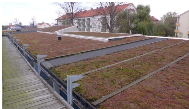
25. attēls. Ekstensīvais zaļais jumts, kas prasa mazāku nesošo konstrukciju noturību un vieglāks apsaimniekošanā, bet, attiecīgi, var uzkrāt mazāk ūdens. Avots: autoru arhīvs
