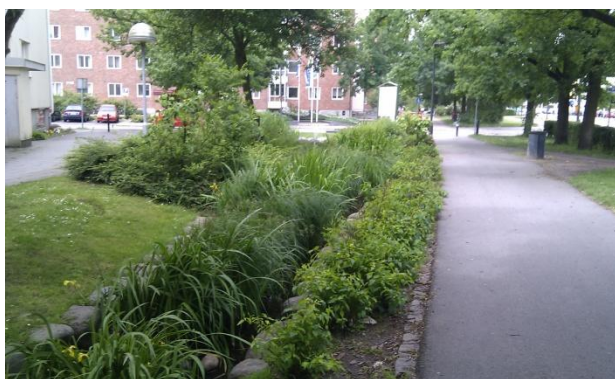
42. attēls. Bioievalka, kas savienojas ar kanālu. Avots: autoru arhīvs
