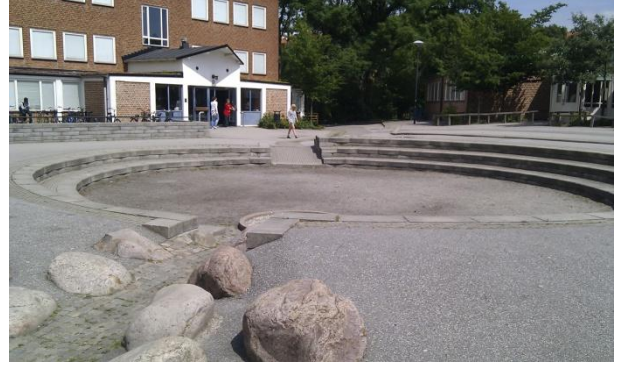
35. attēls. Skolas pagalmā ierīkots amfiteātris, kas lietusgāzes laikā uzkrāj ūdeni. Laika gaitā ūdens infiltrejas gruntī. Ūdens pārplūdes rezultātā tas tiek novadīts likumotajā ievalkā. Avots: autoru arhīvs
