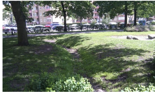
39. attēls. Ūdens no teknēm un daļēji no jumtiem ietek ievalkā. Avots: autoru arhīvs
