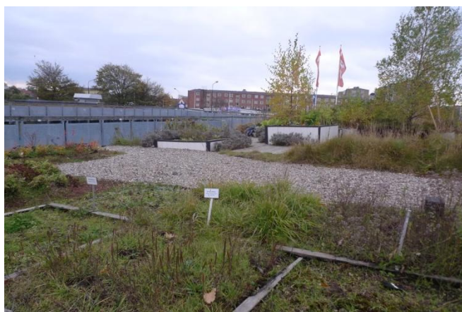
27. attēls. Intensīvais zaļais jumts, kas spēj infiltrēt lielāku ūdens slāni, bet ir prasīgāks pret jumta konstrukcijām un apsaimniekošanu. Avots: autoru arhīvs
