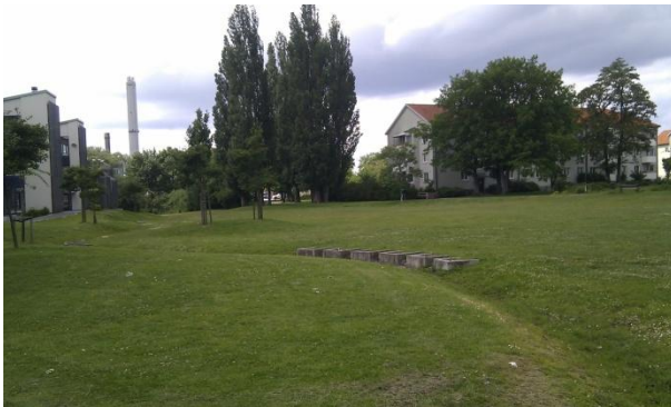
36. attēls. Likumotā Ievalka ar betona blokiem, kuri nodrošina papildu ūdens aerāciju un var tikt izmantoti arī kā soli. Teritorija ap ievalku atrodas zemāk nekā apkārt esošās ēkas un nodrošina papildus ūdens uzkrāšanas tilpumu ekstrēmu lietusgažu laikā. Avots: autoru arhīvs
