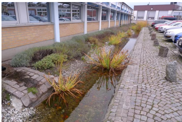
28. attēls. Notece no jumtiem nonāk bioievalkā, notece no stāvlaukuma- uz caurlaidīga seguma. (bruģis). Avots: autoru arhīvs
