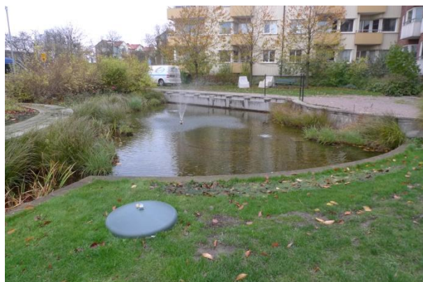
33. attēls. Ieplūstot apakšējā dīķi (ūdens līmenis par 40 cm zemāks nekā augšējā dīķi) ūdens tiek izvadīts caur augu 'filtru'. Ūdens tiek pumpēts atpakaļ uz augšējo dīķi. Liekais ūdens pārplūdes rezultātā caur kolektoru tiek novadīts 'akmens kubu' kanālā. Avots: autoru arhīvs
