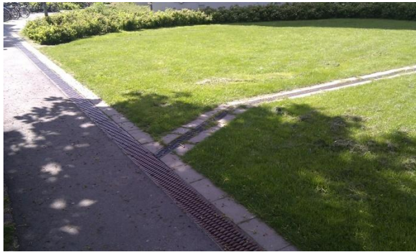
38. attēls. Ūdens no jumtiem tiek novadīts virszemes teknēs. Avots: autoru arhīvs
