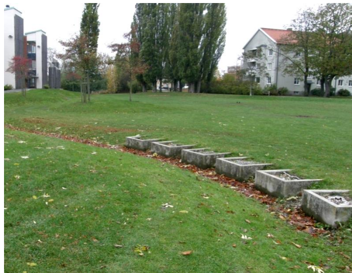
66. attēls. Ievalka ar betona blokiem Augustenborgā, Malmē. Avots: autora arhīvs
