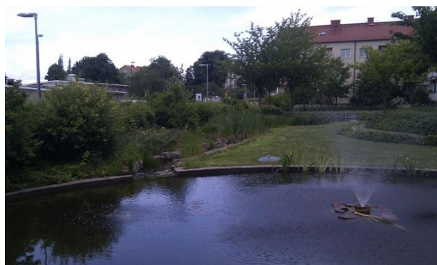
31. attēls. Augšējais dīķis, kur ūdeni attīra ūdens augi un aerāciju sekmē strūklaka. Avots: autoru arhīvs
