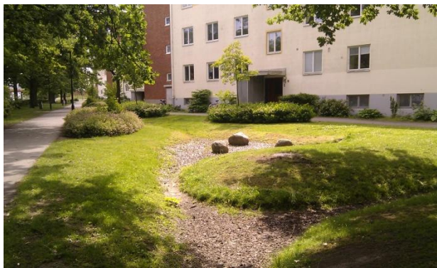
40. attēls. Līkumotā ievalka, kurā ūdens daļēji infiltrejas. Avots: autoru arhīvs
