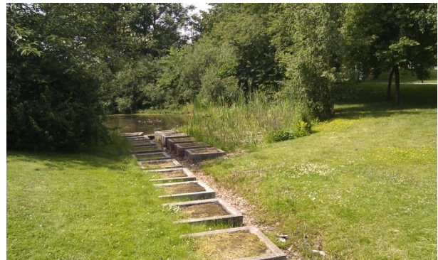
37. attēls. Centrālais noteces koridors noslēdzas ar nelielu dīķi, no kura ūdens pārplūdes rezultātā nonāk lietusūdeņu kanalizācijā. Avots: autoru arhīvs
