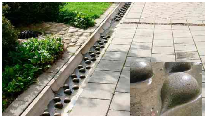
29. attēls. Ūdens teknes, kas savieno māju notekcaurules ar betona kanālu. Teknēs iebūvētas 'betona lāses', kas sekmē ūdens aerāciju. Avots: Stahre (2008)
