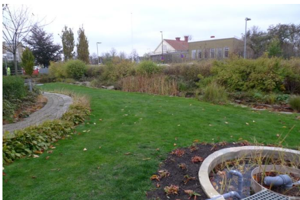
32. attēls. Seklais kanāls/ievalka (attēla augšā), kas savieno augšējo un apakšējo dīķi. Teritorija starp dīķiem nodrošina papildus uzkrāšanas apjomu ekstrēmu lietusgāžu laikā. Avots: Stahre (2008)
