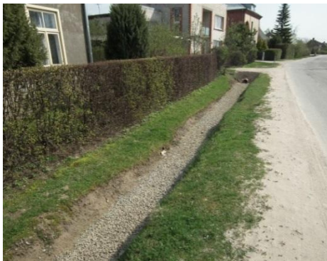
21. un 22. attēls. Rekonstruētā lietusūdeņu apsaimniekošanas sistēma Bauskā, Avots: Bauskas novada dome.
