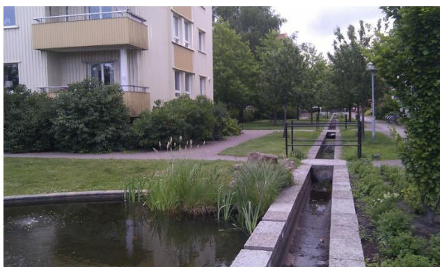
30. attēls. Centrālais kanāls (izbūvēts no betona), kas aizvada lietus ūdeņus dubultajā dīķī. Avots: autoru arhīvs
