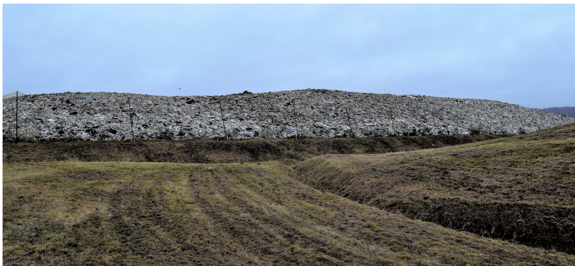
2.4.attēls. Esošā poligona “Grantiņi” atkritumu krātuve (skats no D, no rekultivētās atkritumu izgāztuves puses)
