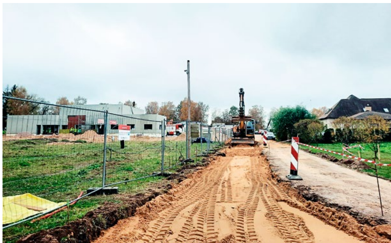
Iecavā notiek piebraucamā ceļa izbūve posmā no valsts reģionālā autoceļa P92.
