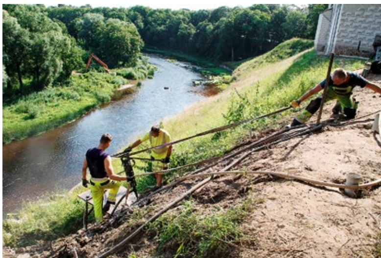
Visā nogāzes platībā pabeigta metāla grunts enkuru un pāļu iebūšana pamatnē.
