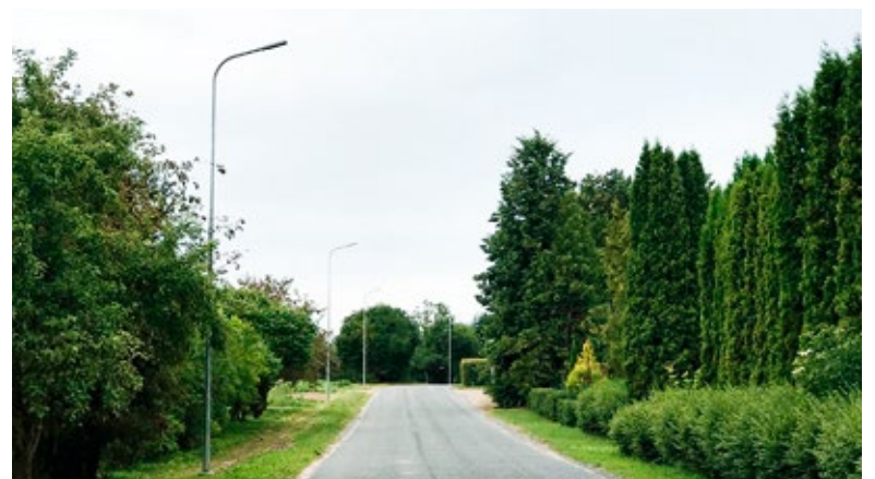
Bauskas novada pašvaldībā uzsākta ielu apgaismojuma modernizācija (pilna servisa ESCO pakalpojums) - novecojušie gaismeķļi tiek nomainīti pret energoefektīviem.
