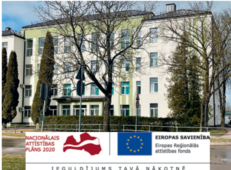
Apjomīgie pārbūves darbi sāksies Bauskas 2. vidusskolas vecajā korpusā.
