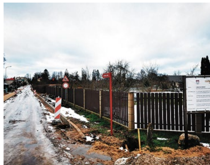
Ceriņu ielas pārbūve Vecumniekos. Ziemas periodā - tehnoloģiskais pārtraukums.
