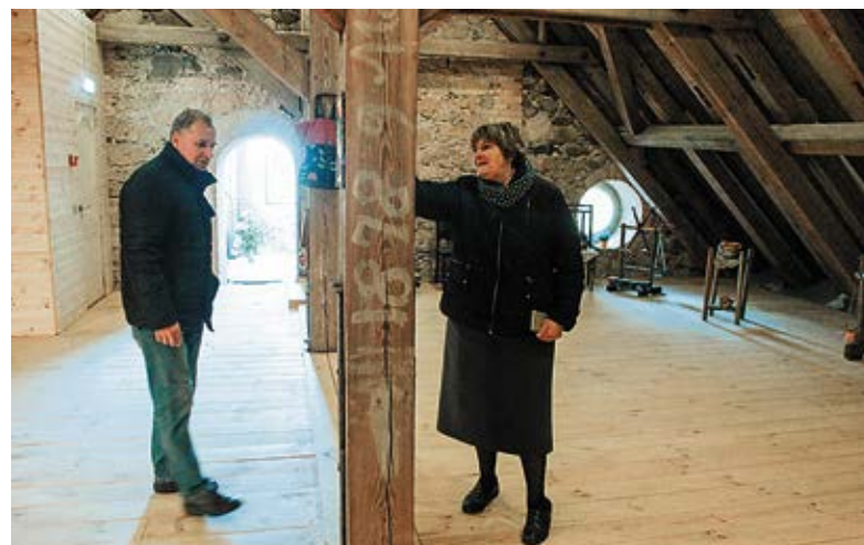
Valles baznīcas draudzes vecākā un projekta vadītāja Diāna Ruģele ar vīru Imantu stāsta par interesantajām vēstures liecībām, kas atklājušās, atjaunojot ēkas konstrukcijas.
