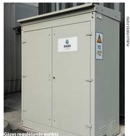
Gāzes regulēšanas punkts
