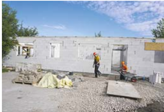
Higiēnas centra būvniecība Rūpniecības ielā 7 jāpabeidz līdz rudenim.
