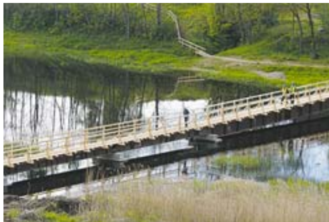
Ir demontēts slikta stāvoklī esošais gājēju tilts pār Mūsu un uzstādīts pagaidu tiltiņš.
