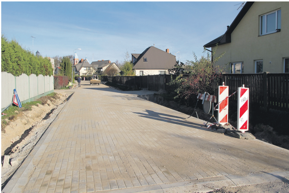
Turpmāk pēc rudens un pavasara lietavām, mērojot ceļu pa l.Maija ielu, iedzīvotājiem vairs nenāksies brīst pa dubļainu grants segumu. Šajā ielā ieklāts bruģis. Bruģis ieklāts arī Sporta ielas posmā, plānots, ka vēl šogad bruģi šajā ielā ieklās arī no Kareivju ielas līdz Pilskalna ielai un pie labvēlīgiem laikaapstākļiem posms no Zemgaļu ielas līdz Krasta ielai tiks asfaltēts.
