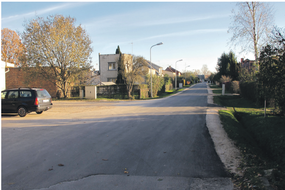
Pārvērtības šajā gadā piedzīvojusi Akāciju iela. Līdzšinējā grants seguma vietā tur tagad ieklāts asfalts
