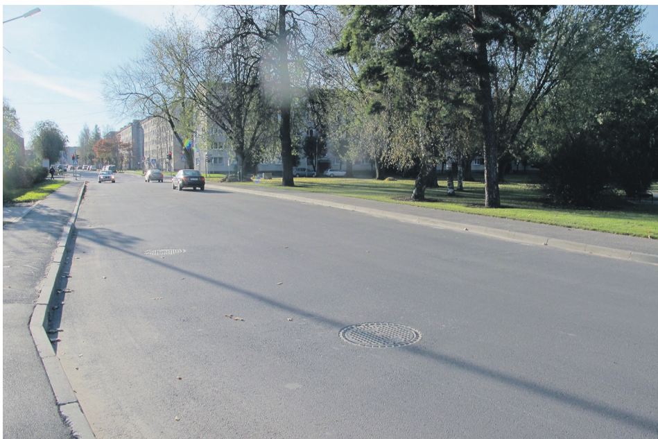
Sakārtots Salātu ielas posms no Dārza ielas līdz Bauzes tirgus iebrauktuvei
