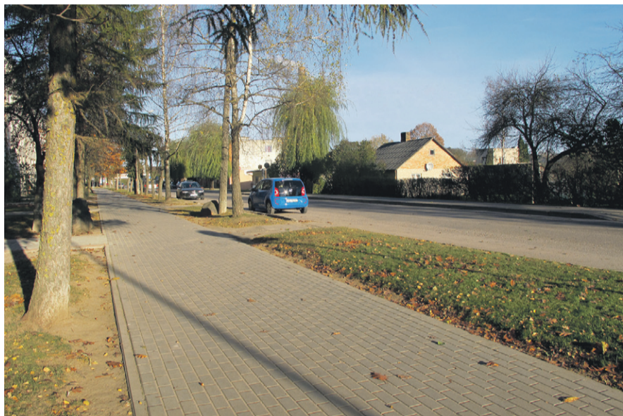
Salātu ielā ieklāts jauns bruģa segums gājēju ietvei
