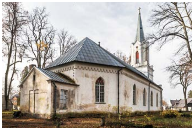
Būvniecības 1. kārtā paredzēti būvdarbi torņa augšējā daļā, tur nomainot gan bojātās koka konstrukcijas, gan novēršot mūra sienu fragmentāciju.
