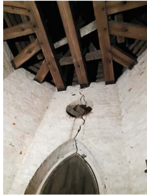
Torņa iekšpusē var pārliecināties, ka vairākas jumta sijas ievērojami trupējušas; klieģu mūra sienas sašķēlušas, par ko liecina logailu zonās redzamas atvērta plaisas.
