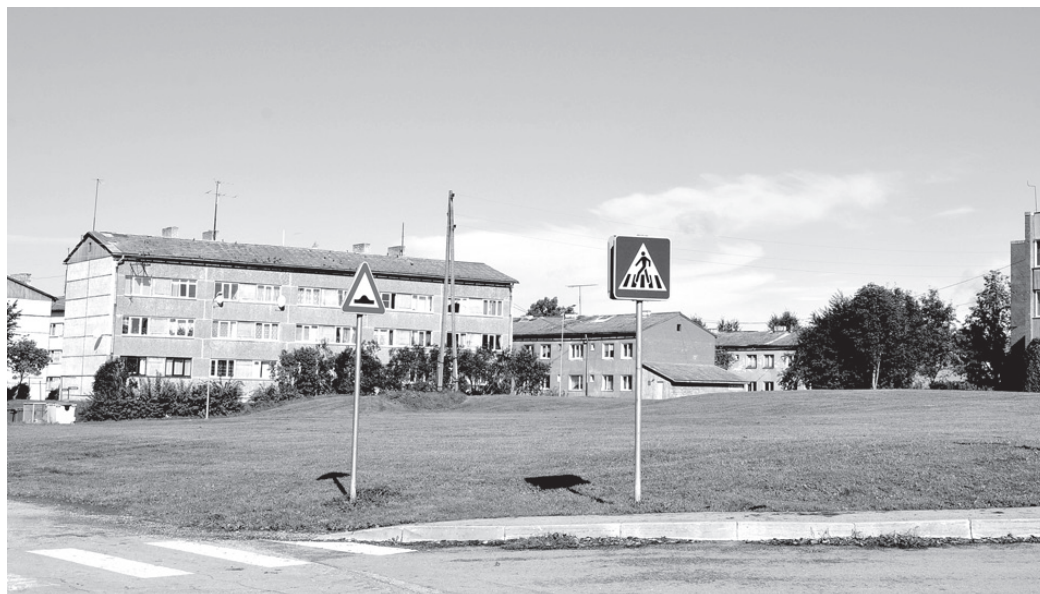
Vecumniekos, Kalna ielā 12, plānots izbūvēt atpūtas laukumu bērniem un jauniešiem.
