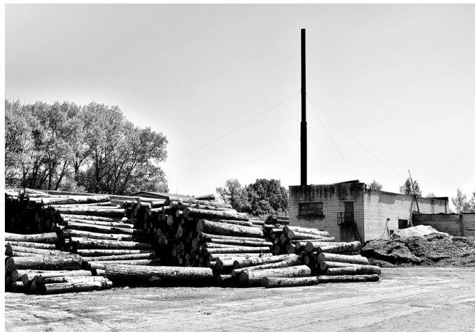
Katlumāja «Īrnieks» nodrošina centralizētu siltumapgādi Vecumnieku ciema Rīgas ielas dzīvojamām mājām un sabiedriskām ēkām, kuru kopējā apkurināmā platība ir 8296,46 m 2 .
