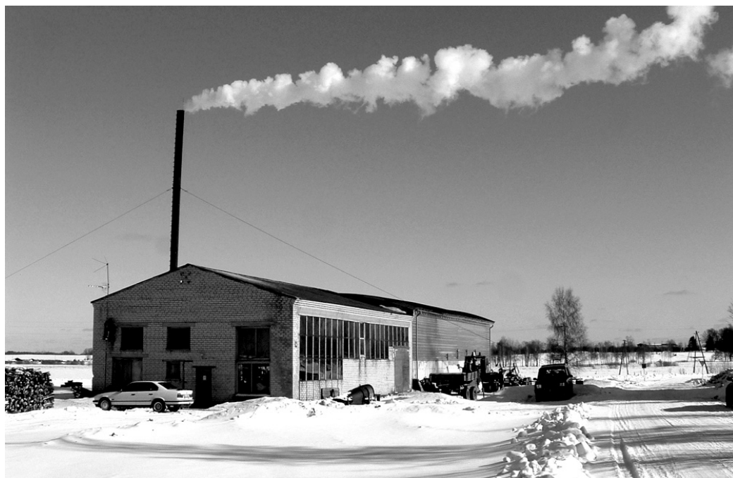
Valles pašvaldības aģentūras pārziņā ir katlumāja Vallē, kas ar siltumu nodrošina daudzdzīvokļu namu iedzīvotājus, vidusskolu, internātu, sporta zāli un pirmsskolas izglītības iestādi «Cielaviņa».
