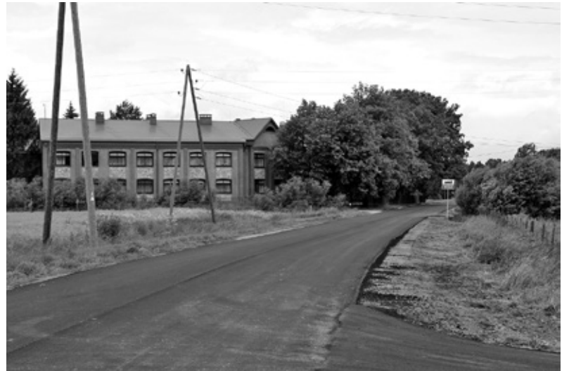
Atjaunotais ceļa segums pie SIA «Iecavnieks» un Valsts sociālās aprūpes centra «Zemgale» Iecavas filiāles.
