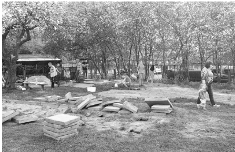
Lai «zaļā zona» būtu drošāka, Dārza ielā 4 tika demontētas vecās betona plāksnes.
