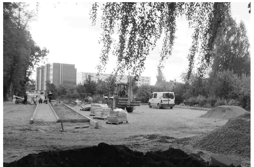
Kādreizējās koku rindas vietā jau ierīkots trotuārs, kam šonedēļ uzsākta bruģa ieklāšana.
