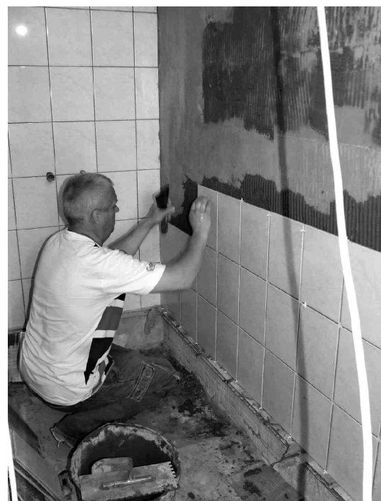
Pēc rekonstrukcijas sanitārais mezgls skolas ēkā Upes ielā 8 būs ērts un mūsdienu prasībām atbilstošs.
