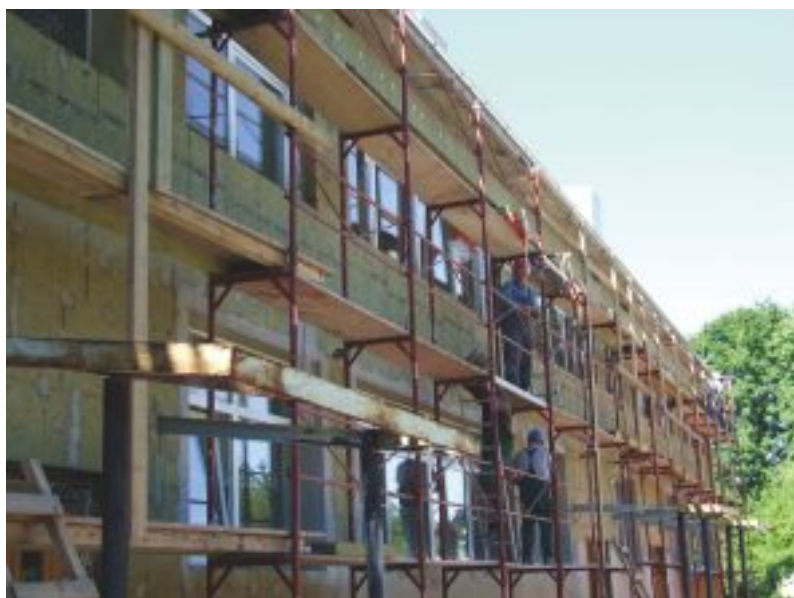
Fasādes siltināšanai būvnieki izmanto akmens vates plāksnes.
